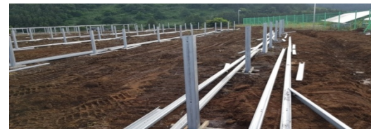
Installation de la structure des poteaux/fixation avec supports en bois
