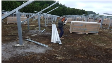
Assemblage de la poutre et de la structure supérieure
