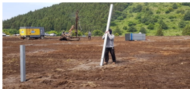
Installation de la structure des poteaux/fixation avec supports en bois
