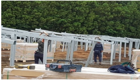
Assemblage de la poutre et de la structure supérieure
