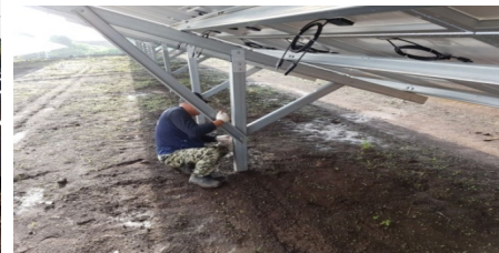
Fixation des modules, boulonnage et finition
