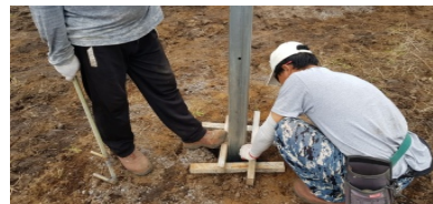
Installation de la structure des poteaux/fixation avec supports en bois
