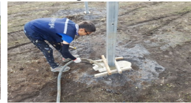
bétonnage du lait (béton/eau/agent d'expansion)
